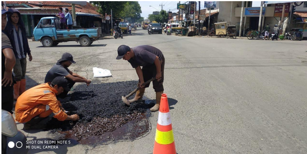
Gambar 1. Kegiatan penambalan jalan dengan lapisan aspal emulsi dilanjutkan dengan gelaran aspal cold mix untuk melakukan perataan permukaan
