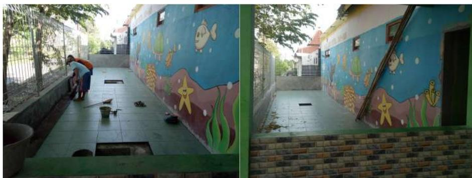
Gambar 6. Pemasangan keramik lantai area bermain yang dikembangkan.
